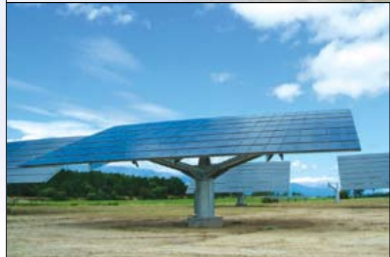
▲ Installation mit Asur in Spanien
