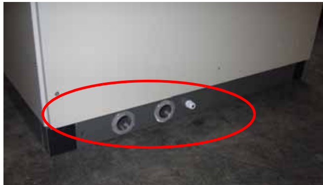
Abbildung 3-6 Position der Kabeldurchführungen
